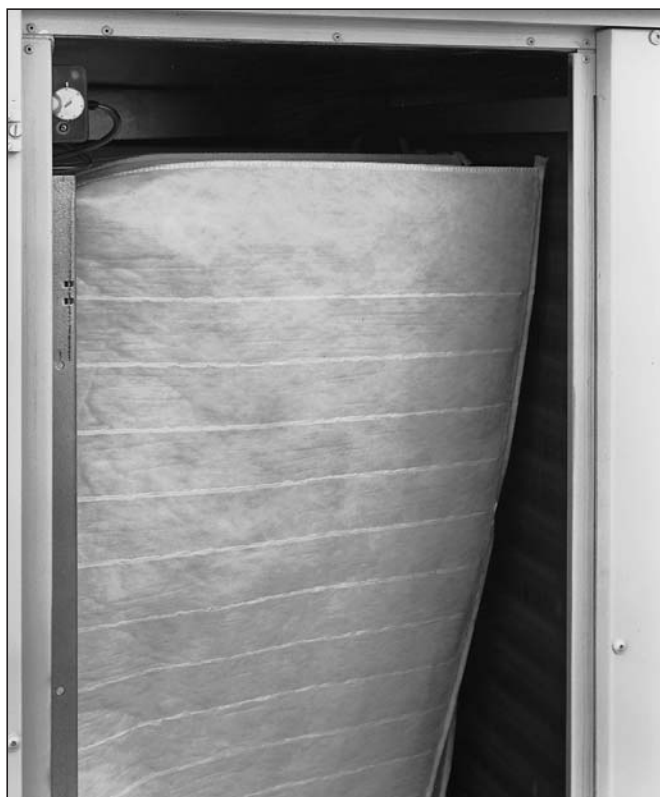
Filtersectie met drukverschilschakelaar
