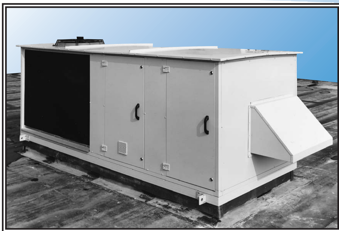
Dakcentrale type BDC7-II, opgesteld bij Hennes & Mauritz te Utrecht/Overvecht Gevuld met koudemiddel R-407C
